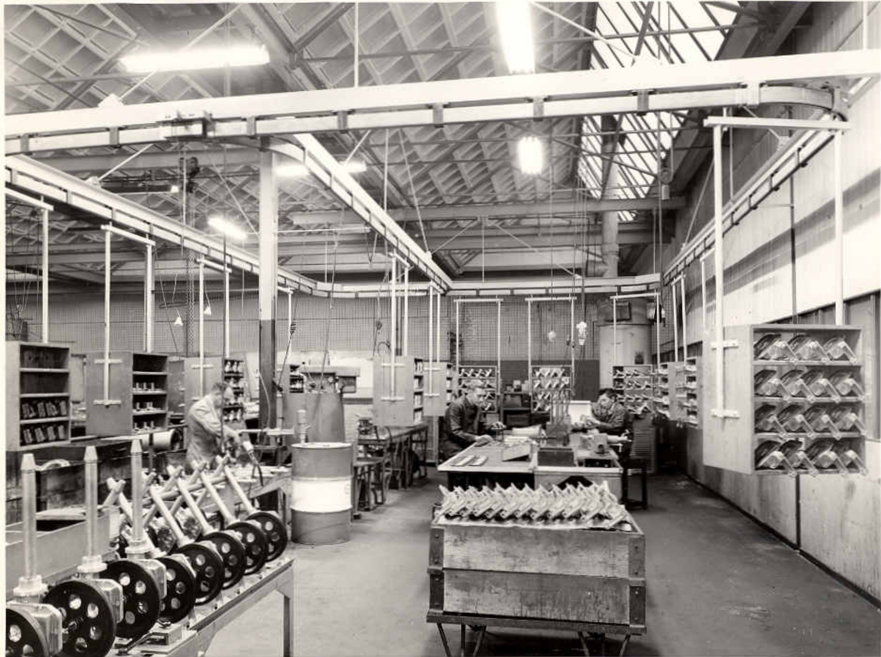
MONTAGE HOEK AANDRUVINGEN VOOR AGITATOR - WASHMACHINE; ENKES PRODUCT
